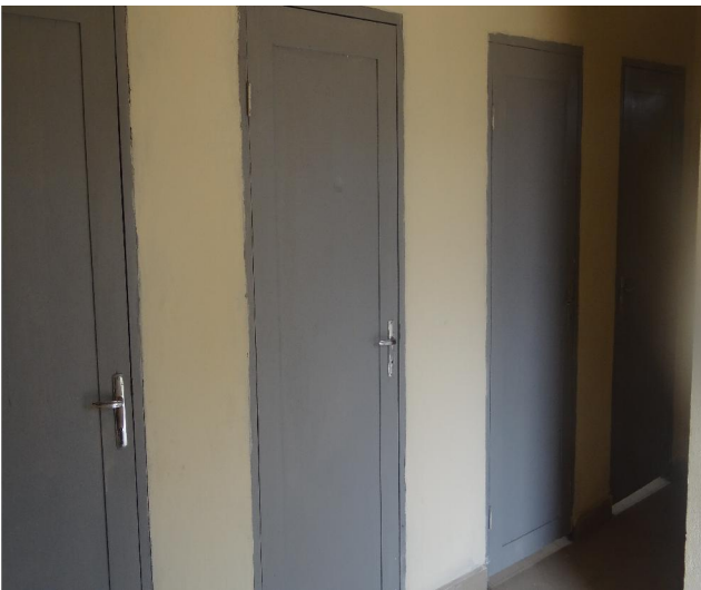
Portes des WC et douches
